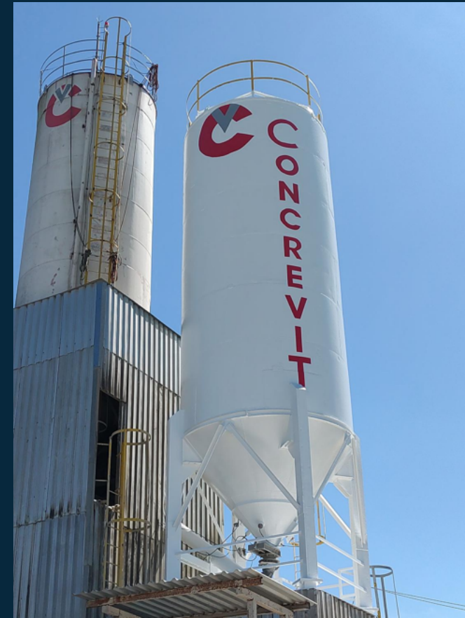
DEPOIS / PINTURA CONCLUÍDA
